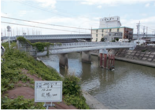
写真1 戎橋水管橋呼び径1000 全景 (橋長 L=43.6m)
