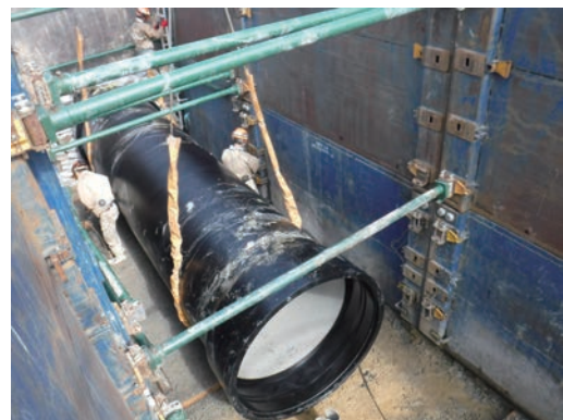
写真2 管接合状況 (US形 呼び径 1500)
