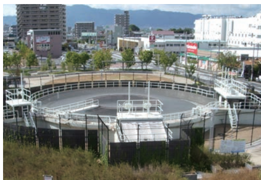
写真1 ビルに囲まれた第1段円型分土工
