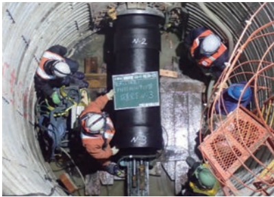
基幹管路整備（推進部 DIP-PN φ600mm）
