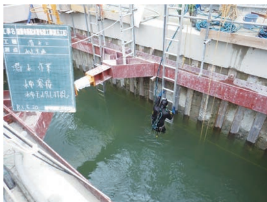
写真6 潜水士による止水作業
