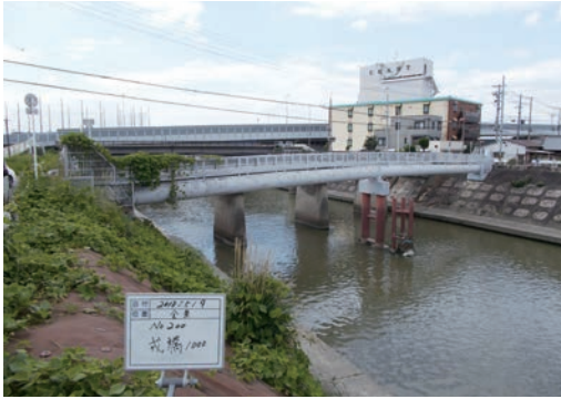
写真1 戎橋水管橋呼び径1000 全景 (橋長 L=43.6m)
