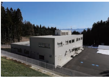
宇津台浄水場全景山側から望む
