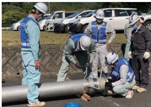
管路応急復旧訓練
