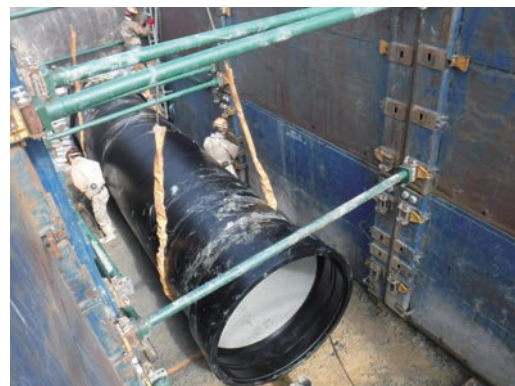
写真2 管接合状況 (US形 呼び径 1500)
