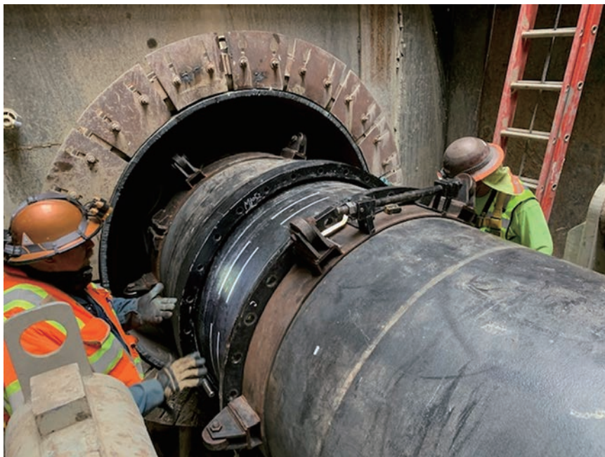
ロサンゼルス市水道電気局 S形 呼び径 1200
