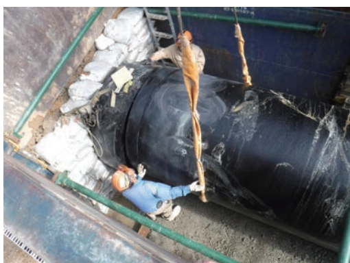
写真5 工事施工風景 (US形 呼び径 1500) ②
