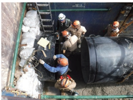
写真4 工事施工風景 (US形 呼び径 1500) ①
