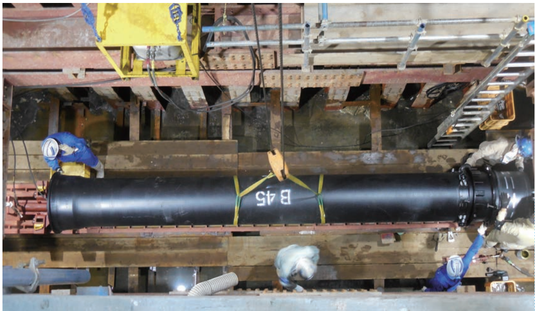
熊本市上下水道局 NS形 呼び径 600
