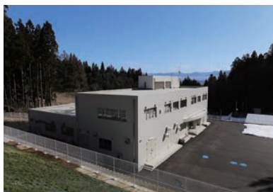
宇津台浄水場全景山側から望む
