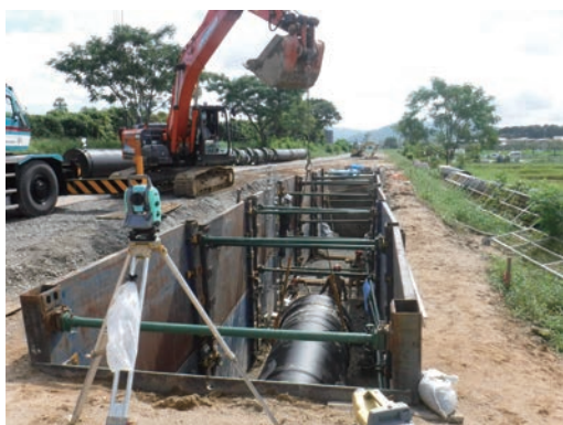
写真3 埋戻し状況 (US形 呼び径 1500)
