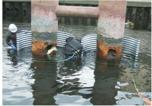
写真2 戎橋水管橋パイルベント橋脚部腐食状況
