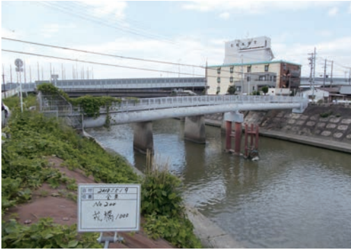
写真1 戎橋水管橋呼び径1000 全景 (橋長 L=43.6m)
