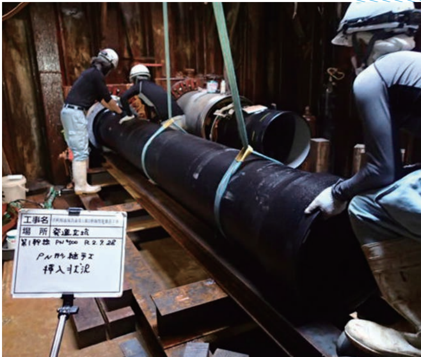
埼玉県荒川左岸北部下水道事務所 PN形 呼び径 500・600
