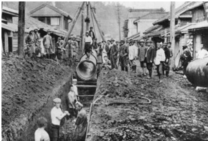
配水管（36 インチ 鑄鉄管）布設工事
