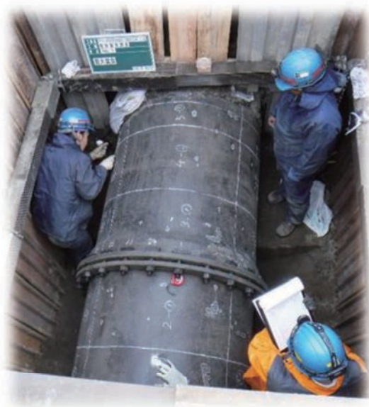
写真1 基幹管路の管体調査(左)、給水管分岐工事等の掘削時の調査(右上) 管体切片の内面ライニング状況の確認(右下)
