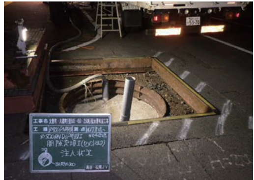
写真11 管理用立坑からの中詰め注入状況
