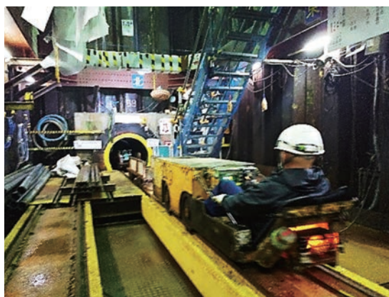
写真11 PN管運搬状況 (バッテリー機関車)
