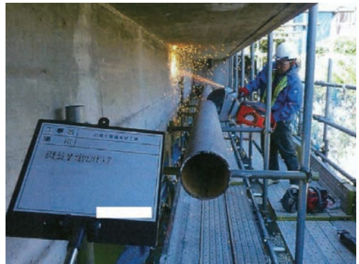
写真4 既設鋼製水管橋の撤去状況
