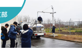
見崎浄水場での給水塔から給水車への給水
