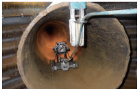
写真6 カメラ調査状況
