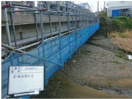
写真3 吊り足場設置状況
