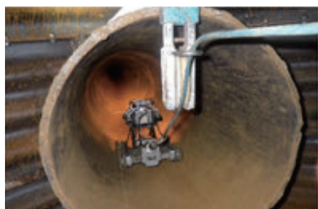
写真6 カメラ調査状況
