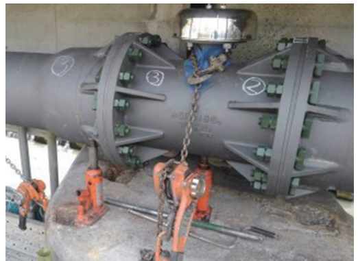
写真6 ボトルジャッキによる据付高さ調整状況
