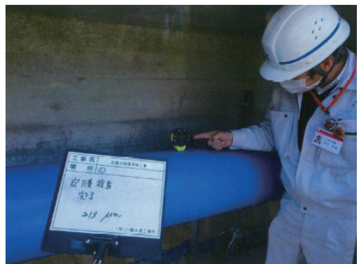
写真8 現地塗装完了後の塗膜厚検査状況
