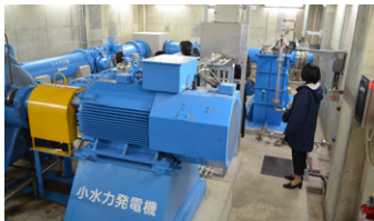
松原浄水場内にある小水力発電施設
