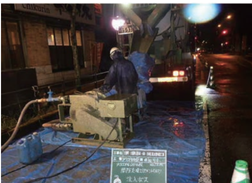
写真10 中詰め注入状況
