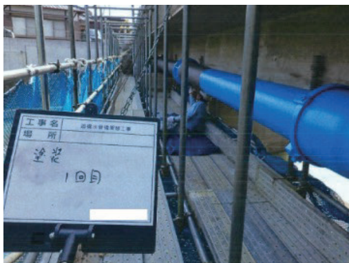
写真7 現地塗装の状況
