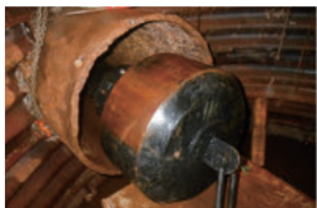
写真5 模擬管調査状況
