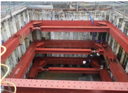
写真13 鋼矢板による立坑
