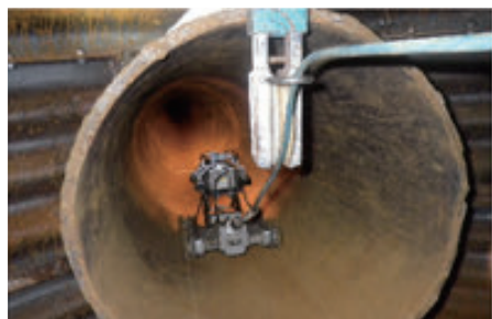
写真6 カメラ調査状況
