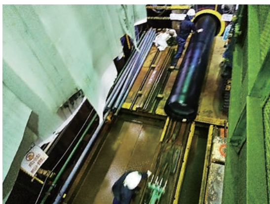
写真10 PN管積載状況 (バッテリー機関車)
