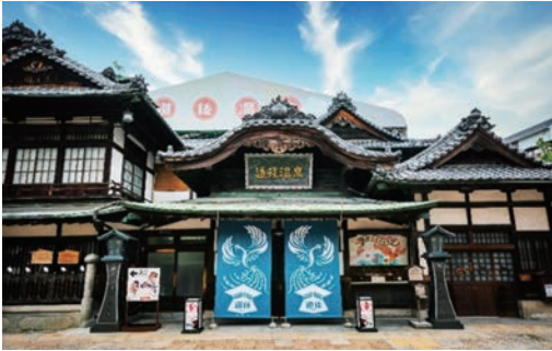
写真2 営業しながら保存修理工事中の 道後温泉本館
