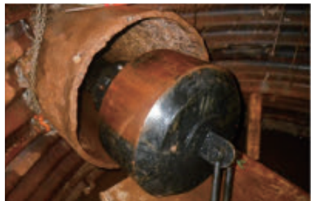
写真5 模擬管調査状況
