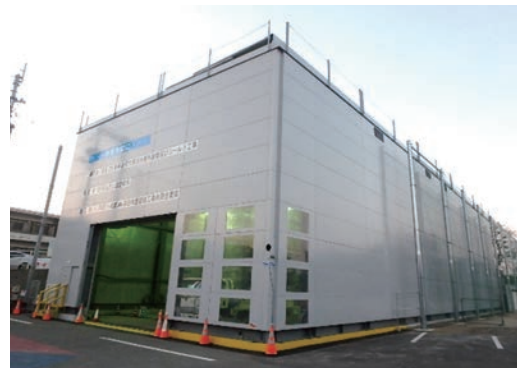
写真14 防音ハウス設置状況
