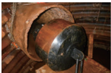
写真5 模擬管調査状況
