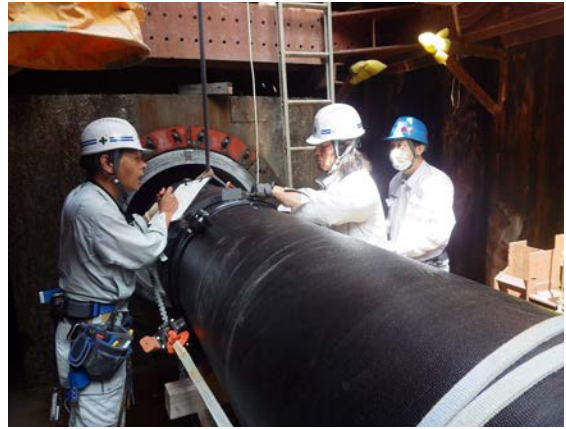
出雲市上下水道局（島根県） PN形 呼び径600
