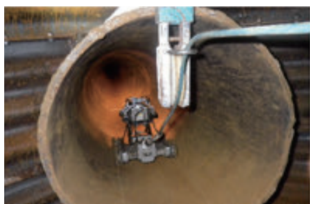
写真6 カメラ調査状況
