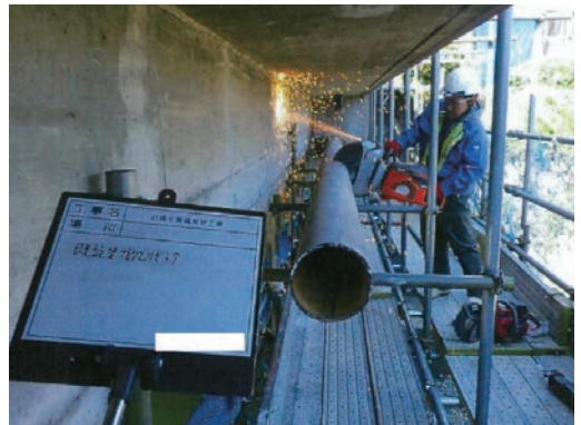
写真4 既設鋼製水管橋の撤去状況
