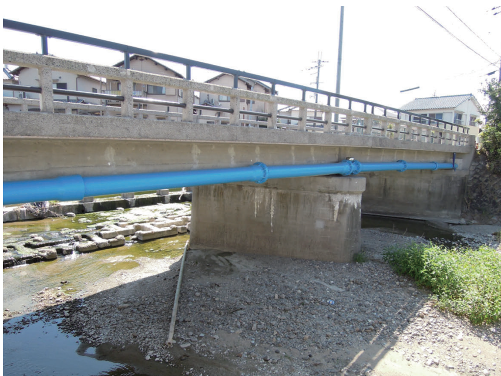
写真9 完成したFGX形ダクタイトイル鉄管製水管橋（呼び径300×25.0m）
