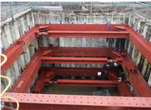
写真13 鋼矢板による立坑
