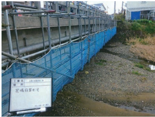
写真3 吊り足場設置状況
