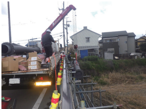
写真5 道路橋上からの管材吊り下ろし状況
