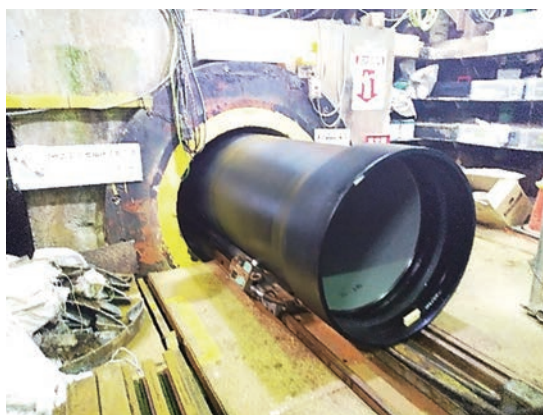
写真12 PN管設置完了
