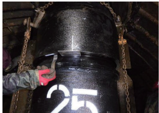
写真7 管接合状況
