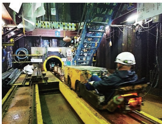
写真11 PN管運搬状況 (バッテリー機関車)
