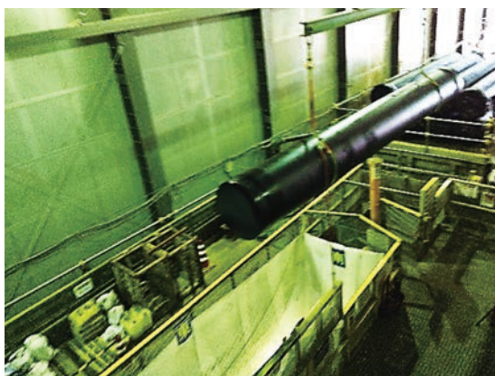
写真9 PN管吊り降ろし状況
