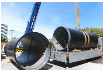
耐震性貯水槽移設工事
