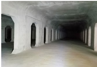
浸水被害軽減に向けて、雨水貯留施設第1弾「麓山貯水池」供用開始
