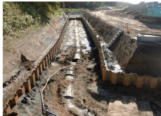
図9 曲管部の移動
