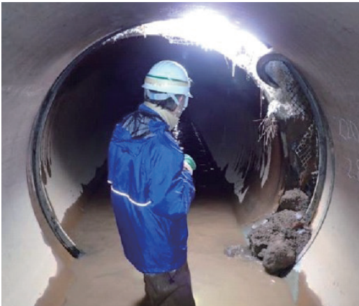
図6 継手の離脱とねじれ
