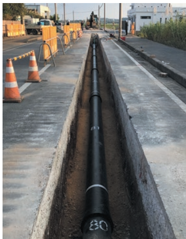
写真1 ビンフ岳1-3号支線水路
