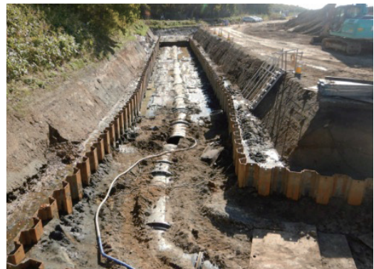
図9 曲管部の移動
