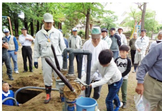
市民の皆さんの参加による耐震性貯水槽 操作訓練を実施
