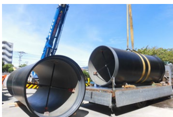
耐震性貯水槽移設工事
