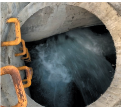
写真1 雨水枡排水状況
