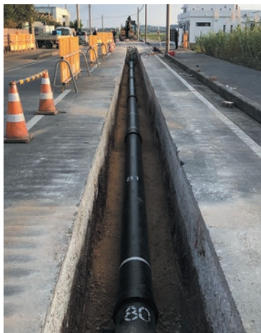
写真1 ビンフ岳1-3号支線水路
