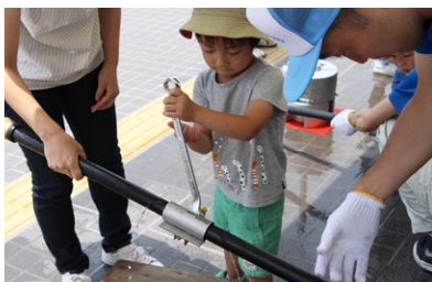
漏水修理体験
