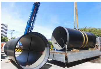
耐震性貯水槽移設工事
