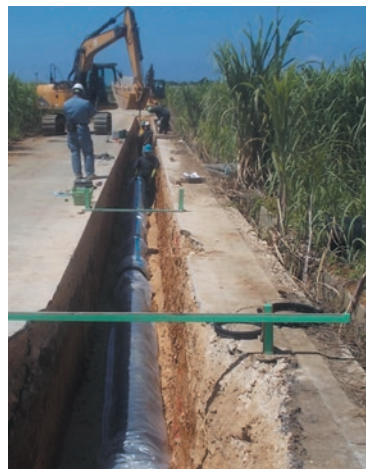
写真2 野原岳2-1号支線水路
