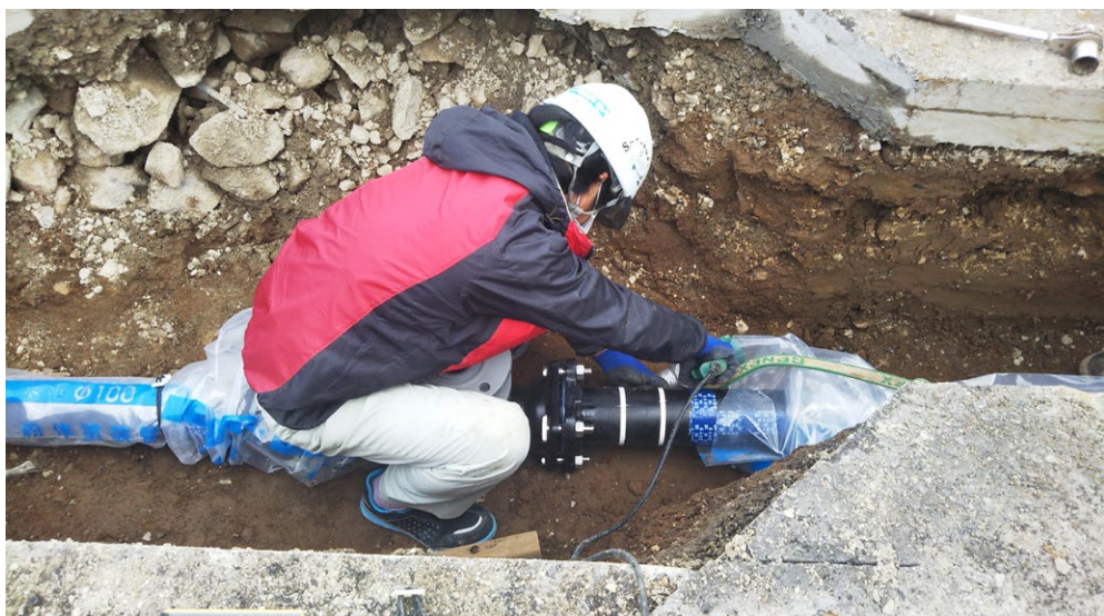
諫早市上下水道局水道課（長崎県） NS形E種 呼び径100×5m
