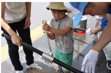
漏水修理体験
