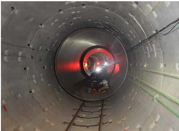
東京都水道局 US形 (R方式) 呼び径 2600
