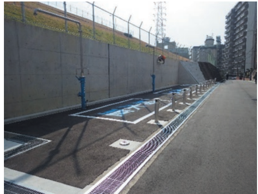
写真1 応急給水栓(寺内配水池)
