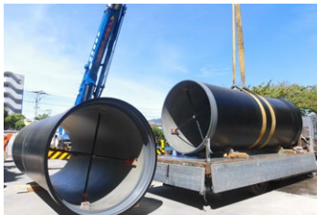
耐震性貯水槽移設工事
