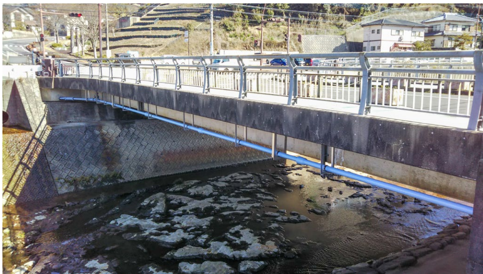
長与町水道課（長崎県） NS形E種 呼び径100×5m（橋梁添架）
