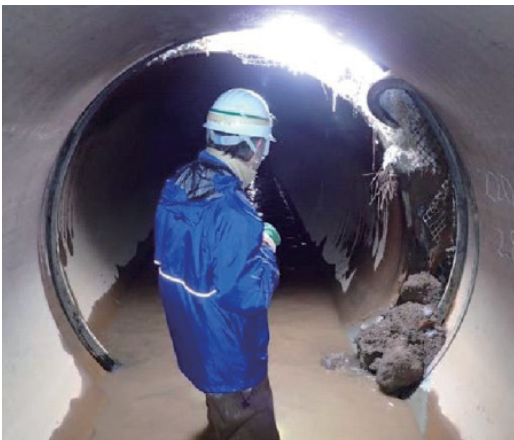
図6 継手の離脱とねじれ
