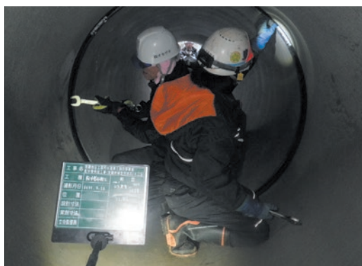
写真4 ダクタイトイル鉄管接合状況
