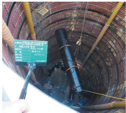
写真3 発進立坑内PN形管吊り降ろし
