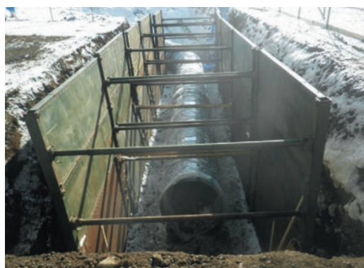
写真5 ダクタイトイル鉄管布設完了状況
