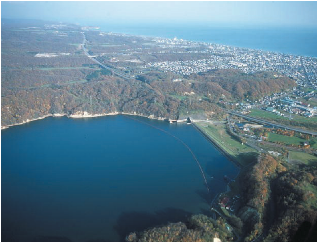
写真1 「幌別ダム」上空から太平洋を望む
