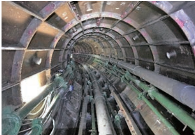
掘削が進むシールドトンネル
