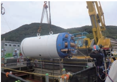
本市初の水道用鞘管シールド工法
