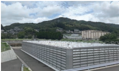
更新した山の田浄水場と配水池
