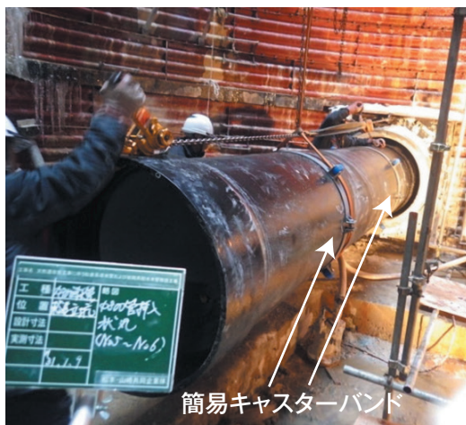
写真4 φ800PN形さや管内挿入状況
