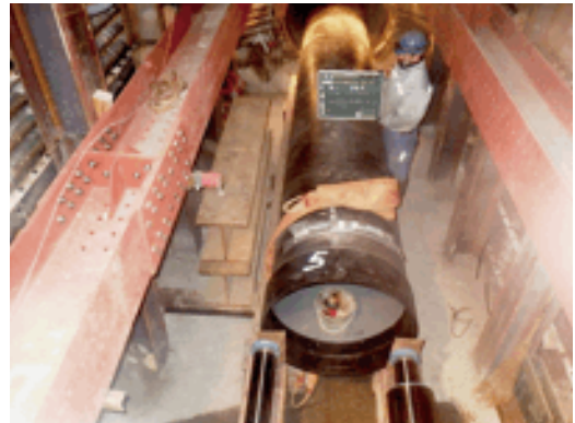
写真2 管挿入状況
