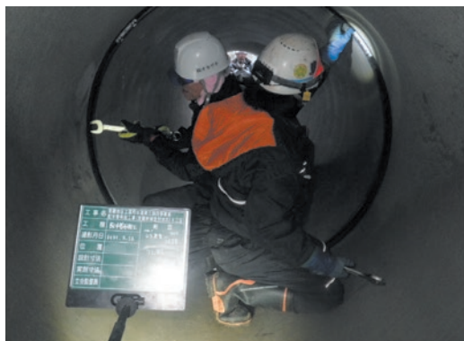
写真4 ダクタイトイル鉄管接合状況
