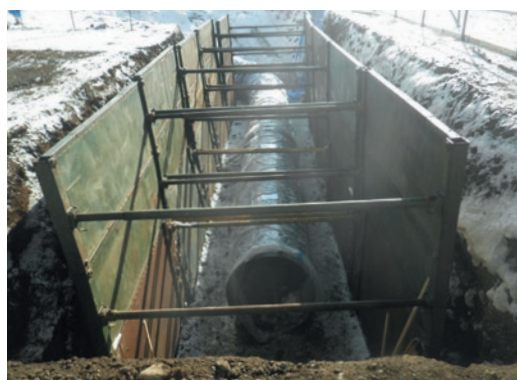
写真5 ダクタイトイル鉄管布設完了状況
