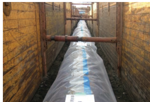
写真3 ダクタイル鉄管布設完了状況
