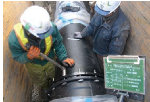
写真2 ダクタイル鉄管接合状況
