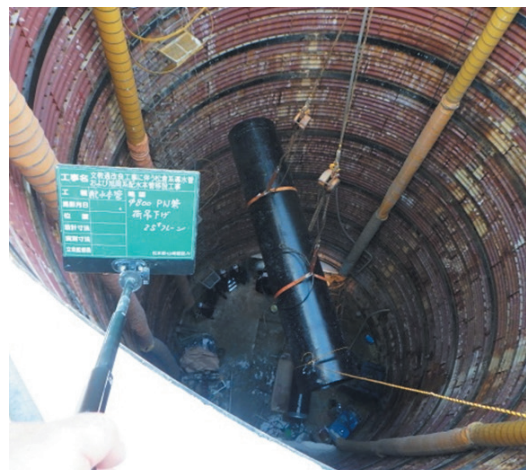
写真3 発進立坑内PN形管吊り降ろし
