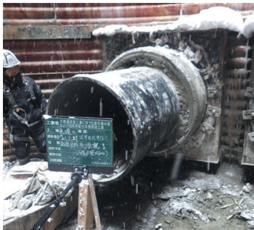
写真5 エアモルタル充填完了
