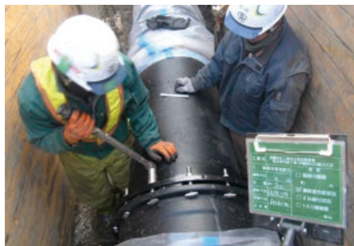
写真2 ダクタイル鉄管接合状況
