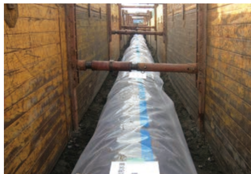
写真3 ダクタイル鉄管布設完了状況
