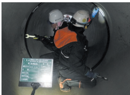
写真4 ダクタイトイル鉄管接合状況
