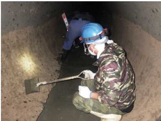
写真1 既設管内インバート工の状況
