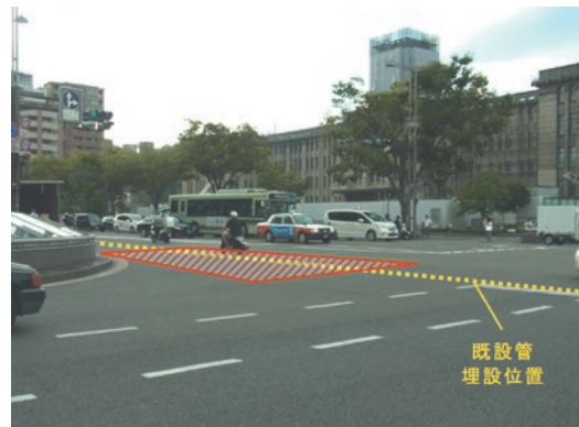
写真5 立坑設置予定箇所(No.4)
