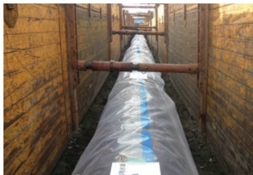
写真3 ダクタイル鉄管布設完了状況
