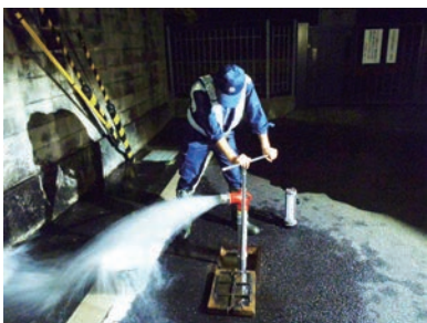
消火栓からの放水
