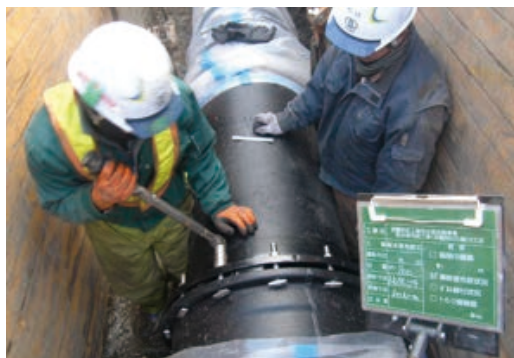
写真2 ダクタイル鉄管接合状況
