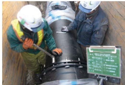
写真2 ダクタイル鉄管接合状況
