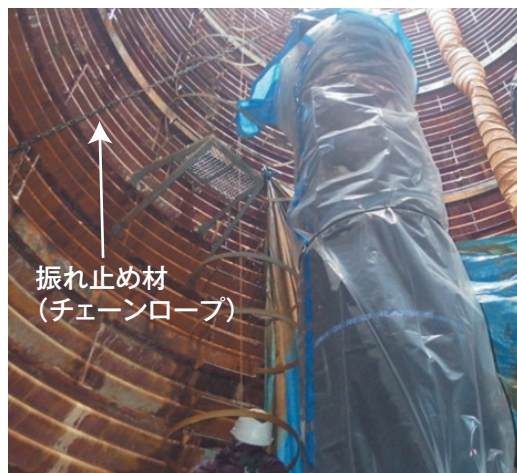
写真7 立坑内NS形配管(振れ止め材)
