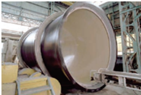
モルタルライニング施工状況
