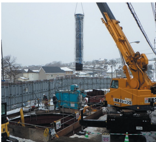
写真6 立坑内NS形管吊り降ろし
