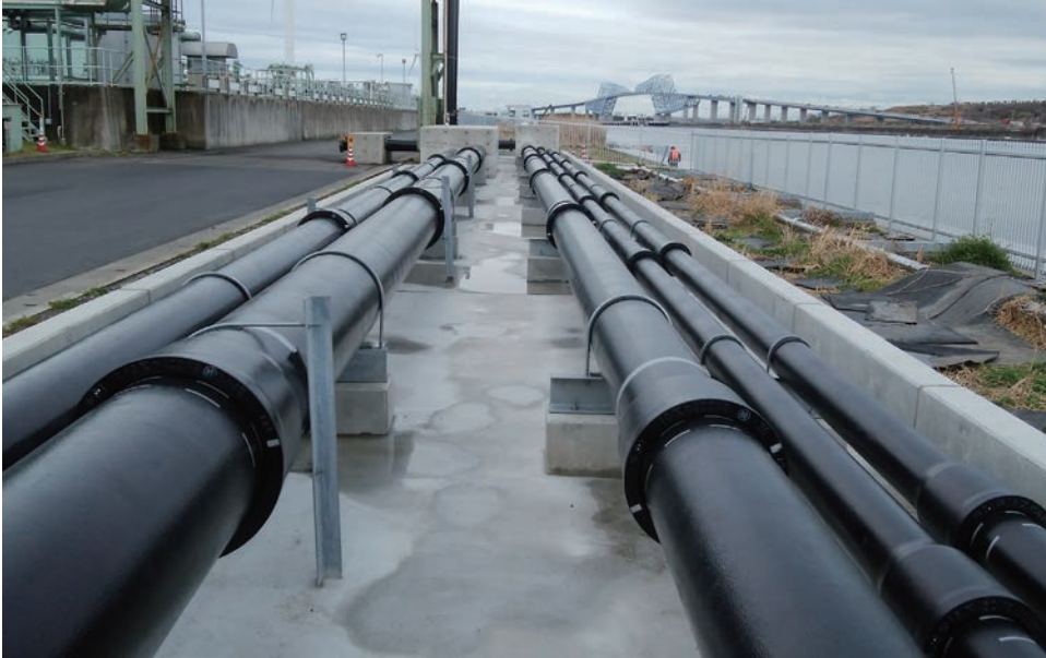
東京都環境局廃棄物埋立管理事務所 NS形 呼び径 300・400・300・150・150
