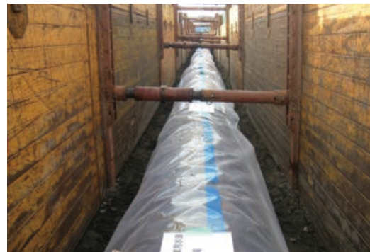
写真3 ダクタイル鉄管布設完了状況
