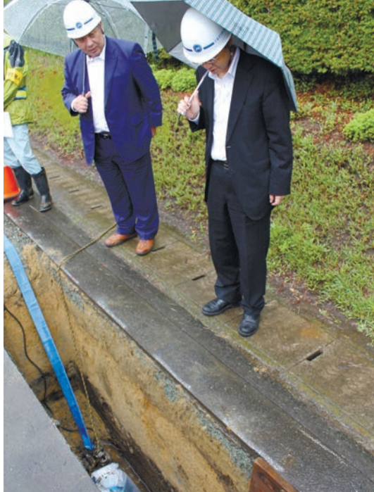
モデル事業による管路工事現場を視察する滝沢教授④
