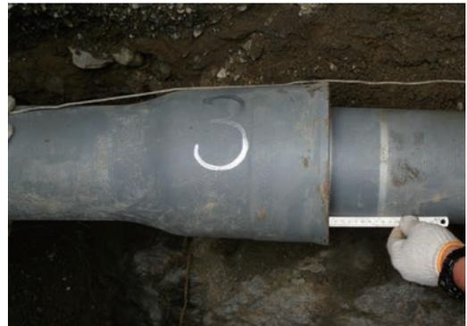
写真3 計測状況(継手の測定)
