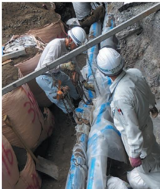
写真4 管の吊り上げ状態と土嚢設置
