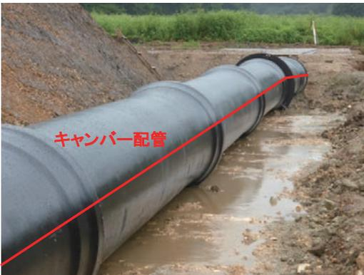
写真1 キャンバー配管の状況
