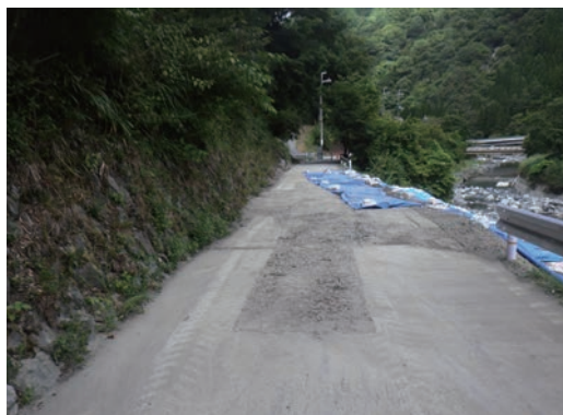
写真5 仮復旧後の状況
