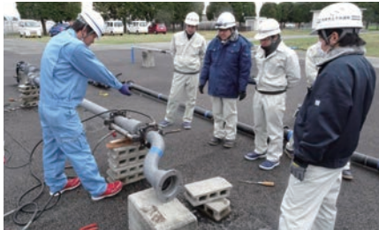
日本ダクタイル鉄管協会の協力による配管実技研修
