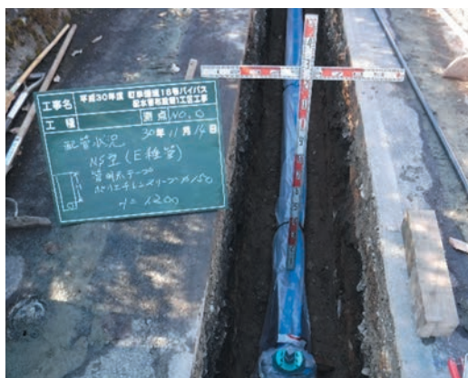
写真3 接合の完了とポリエチレンスリーブによる被覆
