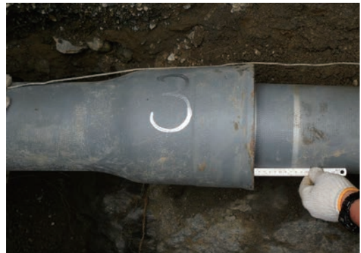
写真3 計測状況(継手の測定)
