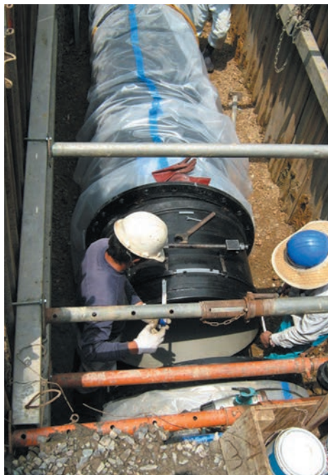
写真1、2 北部福岡緊急連絡管 呼び径900 S形ダクタイル鉄管布設状況
