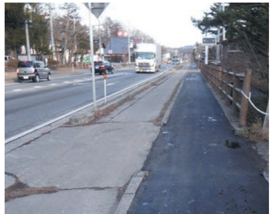
写真4 施工現場の全景 シーズン中は、車道・歩道とも交通量が多い
