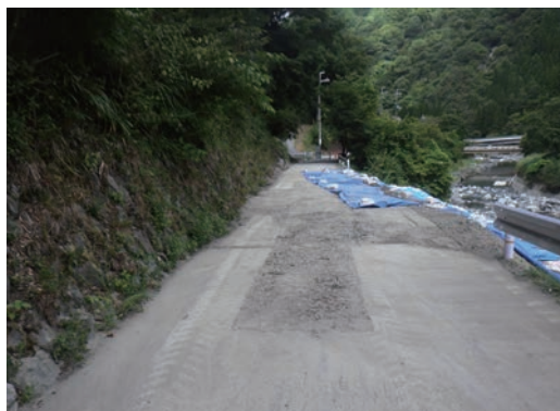
写真5 仮復旧後の状況
