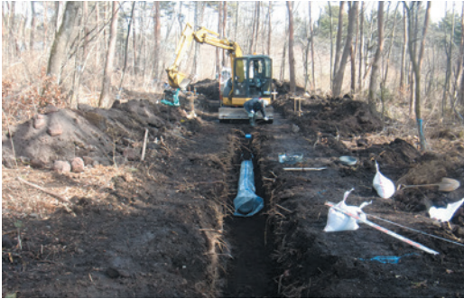
写真4 国有林野内作業道部 水道管布設状況
