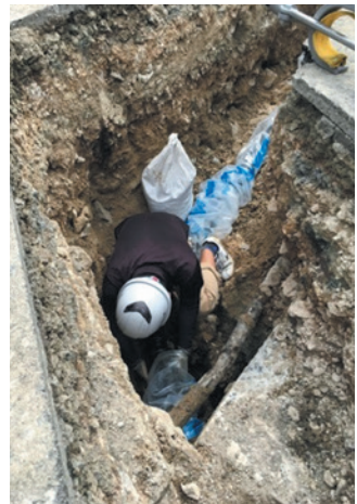
写真2 NS形E種施工状況
