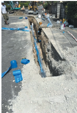
写真2 NS形E種施工状況
