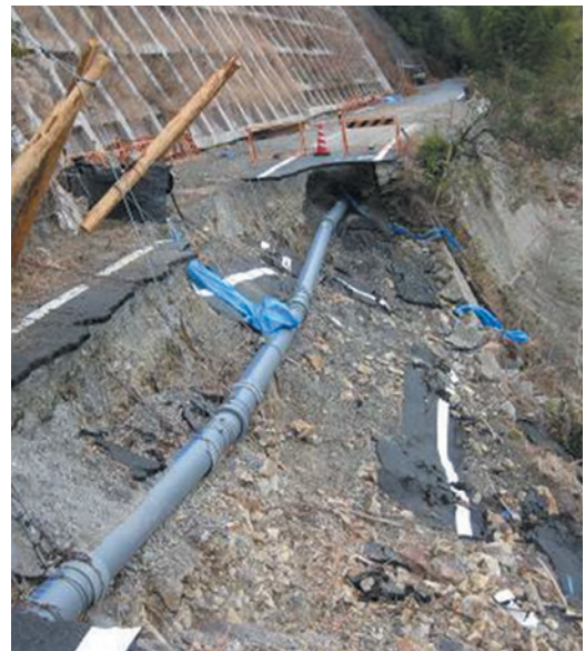
写真3 管路の状況(φ250 GX形)
