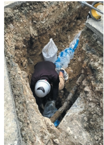
写真2 NS形E種施工状況
