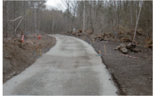
写真5 国有林野内作業道 碎石舗装状況
