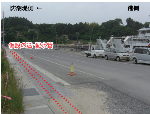
写真6 埋戻し完了
