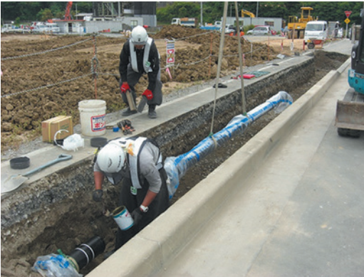
写真4 直管の接合作業
