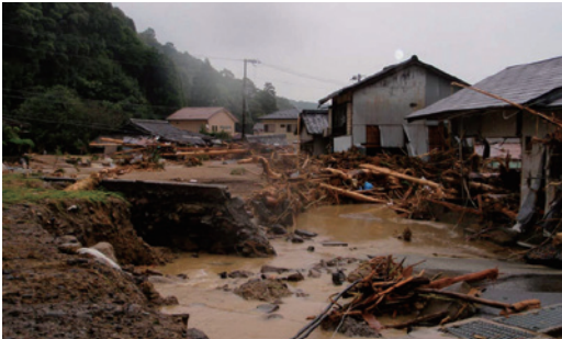
写真1 那智川流域の被害状況 (H23)
