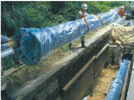
写真1 ポリエチレンスリーブの施工例
