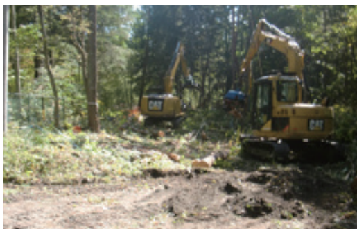
写真2 国有林野伐採状況
