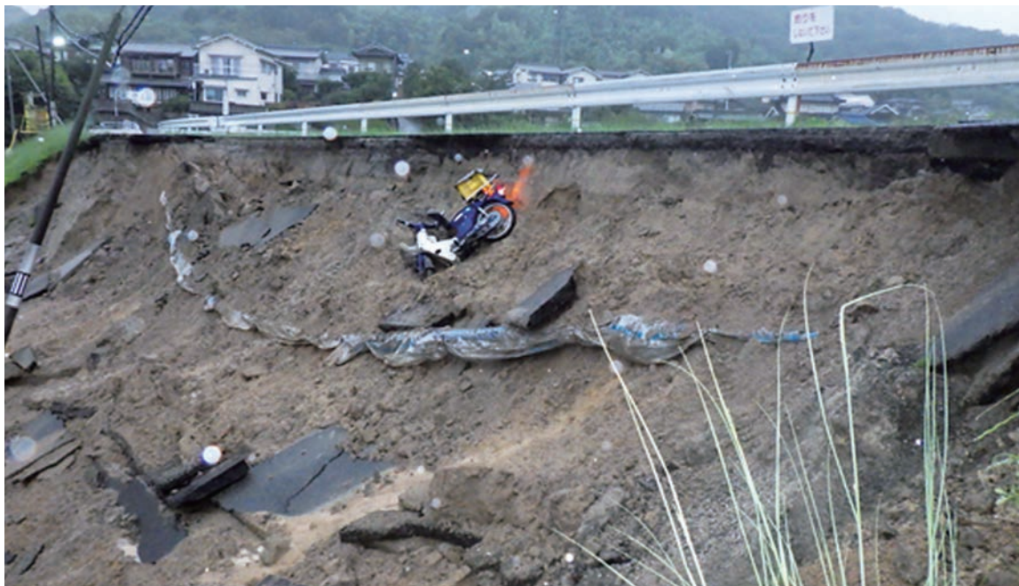
平成30年7月豪雨 尾道市（φ150 SII形）道路は崩壊していたが、漏水はなかった
