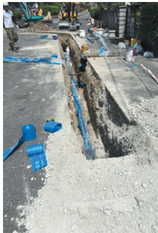
写真2 NS形E種施工状況
