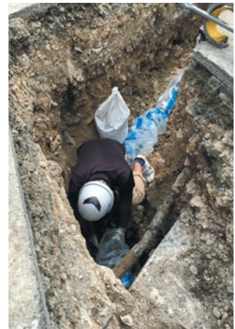
写真2 NS形E種施工状況
