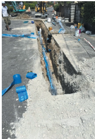
写真2 NS形E種施工状況
