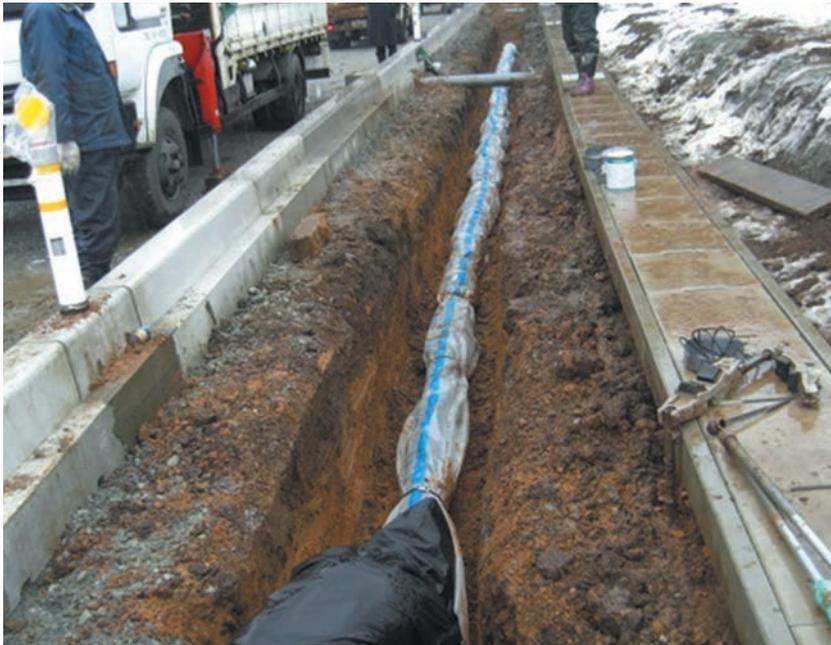
写真5 ポリエチレンスリーブの施工
