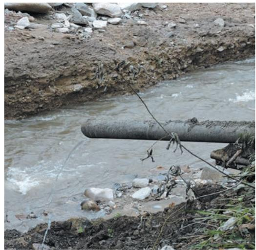
写真2 呼び径200 A形継手離脱状況
