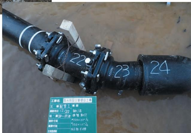
写真10 呼び径150 NS形(E種管)布設状況
