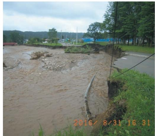
写真4 呼び径200硬質塩化ビニル管流失状況
