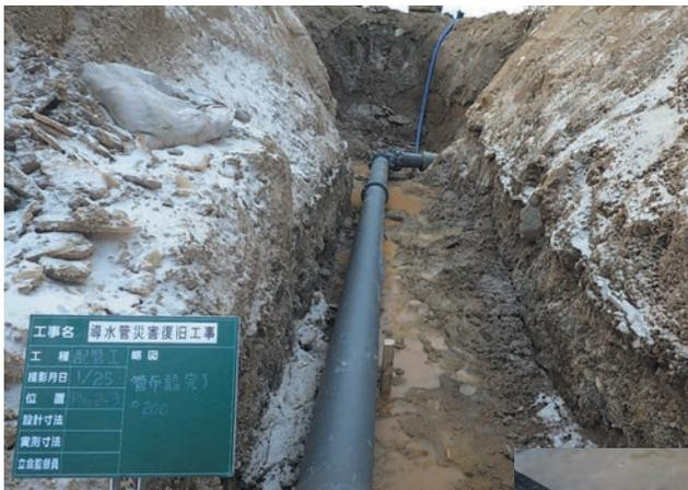
写真9 呼び径200 GX形布設状況
