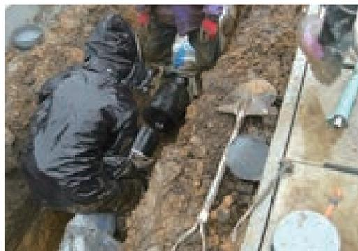
写真2 NS形E種の雨天時の接合
