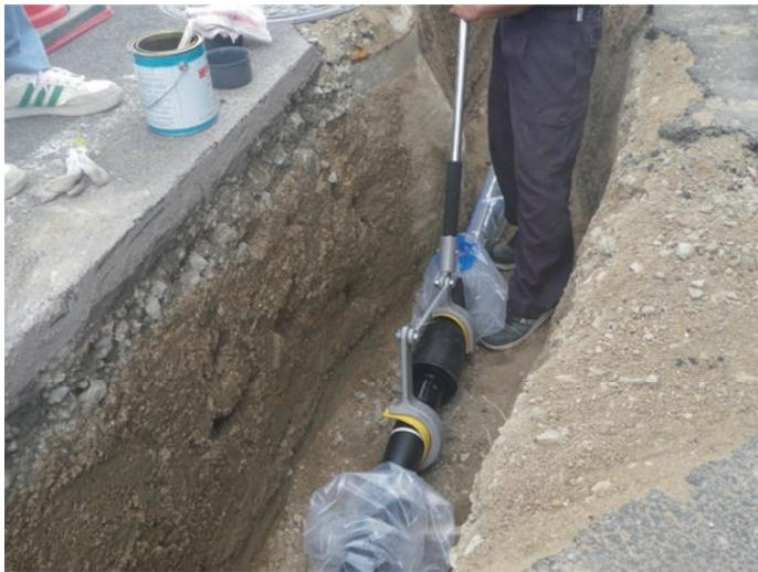
写真1 NS形E種管の施工状況
