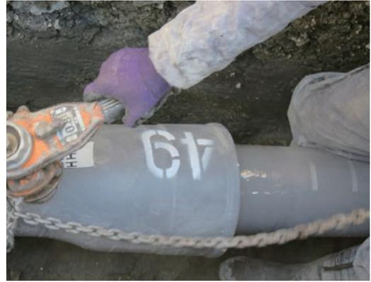
写真2 GX形接合作業状況
