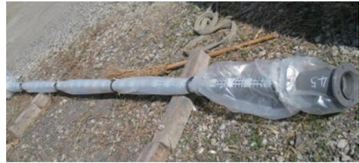
写真6 ポリエチレンスリーブ施工状況
