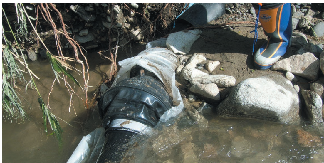
写真3 呼び径200 NS形継手の状況
