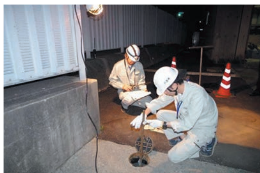
写真2 直結配水切替作業
