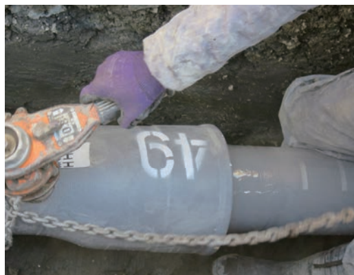
写真2 GX形接合作業状況
