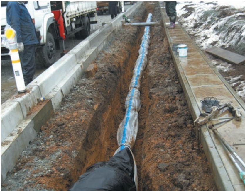
写真5 ポリエチレンスリーブの施工
