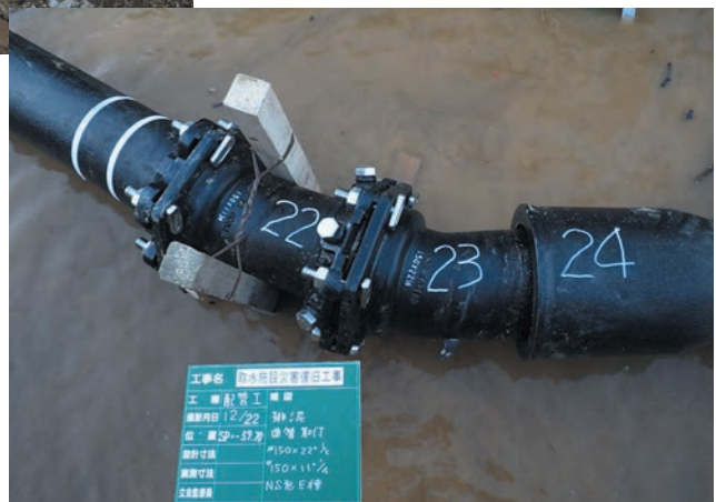
写真10 呼び径150 NS形(E種管)布設状況
