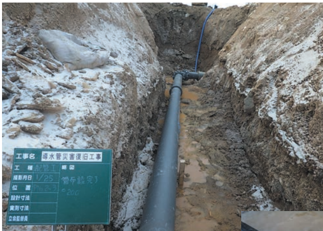
写真9 呼び径200 GX形布設状況
