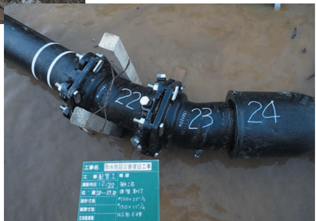
写真10 呼び径150 NS形(E種管)布設状況
