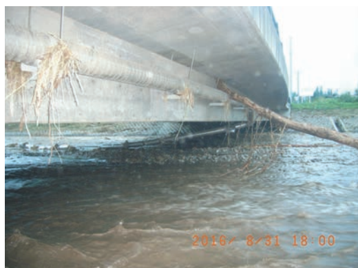
写真5 呼び径75鋼管の状況①
