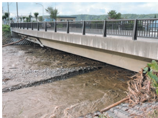
写真6 呼び径75鋼管の状況②
