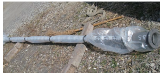
写真6 ポリエチレンスリーブ施工状況
