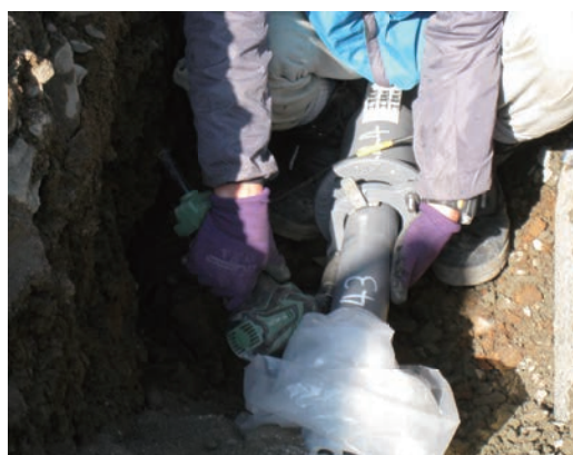
写真3 S50形接合作業状況
