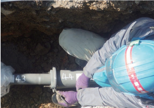
写真4 メタルタッチ確認状況
