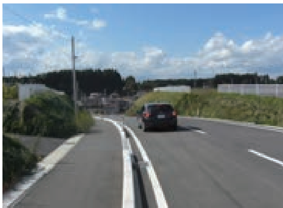
写真3 道路の曲線部
