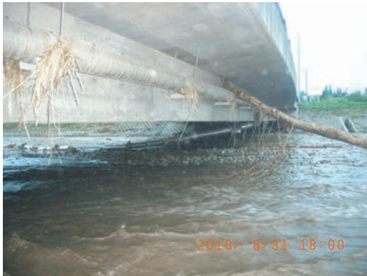
写真5 呼び径75鋼管の状況①
