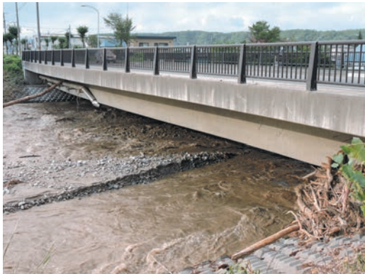
写真6 呼び径75鋼管の状況②
