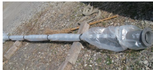
写真6 ポリエチレンスリーブ施工状況
