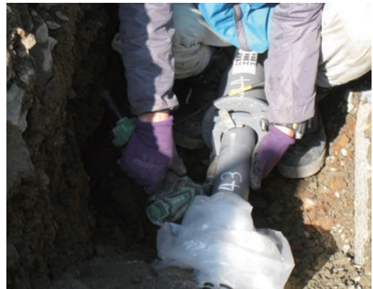
写真3 S50形接合作業状況
