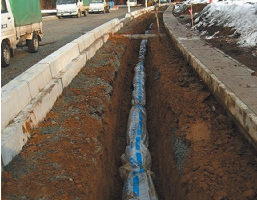
写真4 曲線配管
