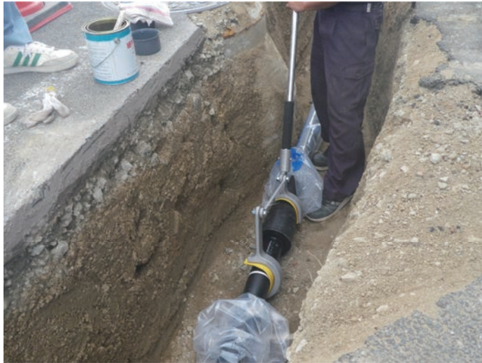
写真1 NS形E種管の施工状況
