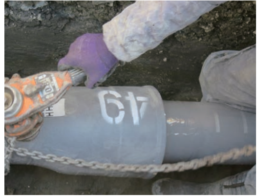
写真2 GX形接合作業状況
