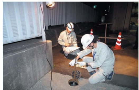
写真2 直結配水切替作業
