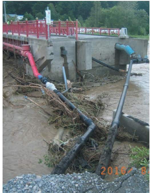
写真7 道路が流されても耐える 呼び径200 NS形ダクタイル鉄管①
