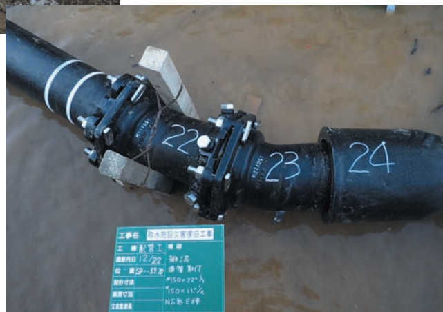
写真10 呼び径150 NS形(E種管)布設状況
