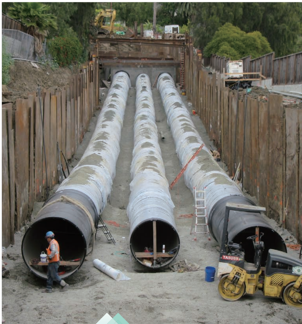
アメリカ合衆国 サンタクララバレー用水供給 S形 呼び径 1500・1650・1800
