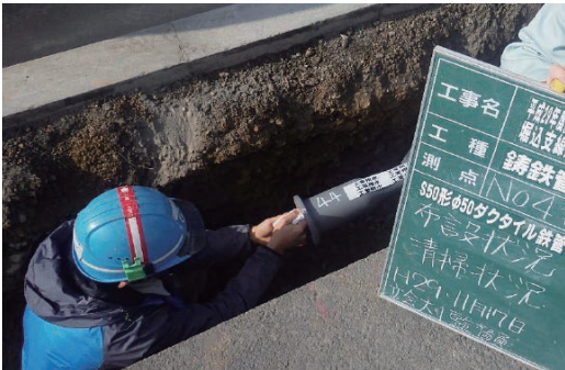
写真5 接合前清掃状況
