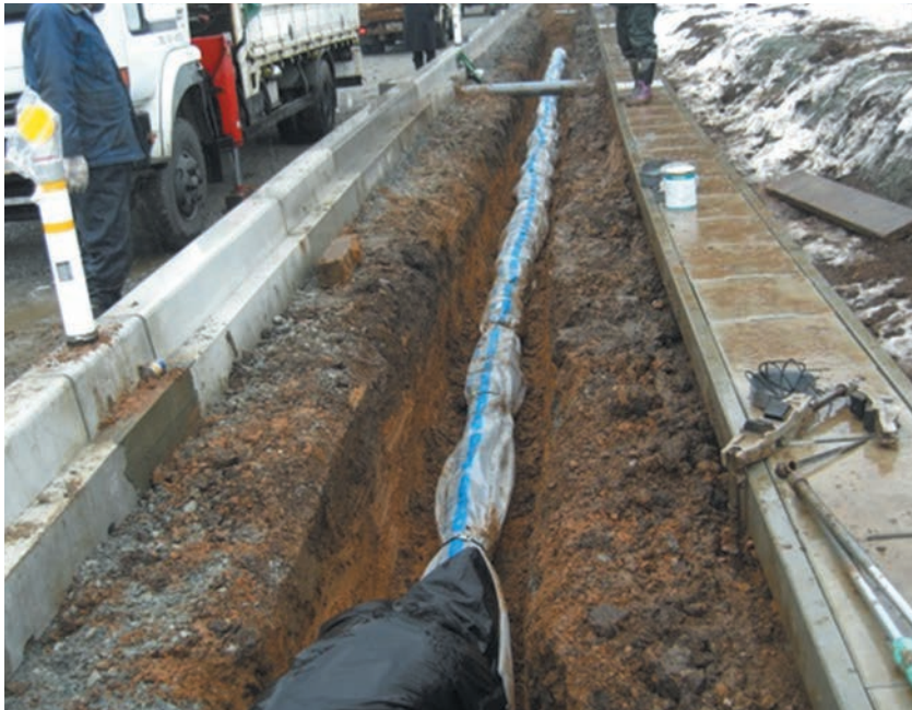
写真5 ポリエチレンスリーブの施工
