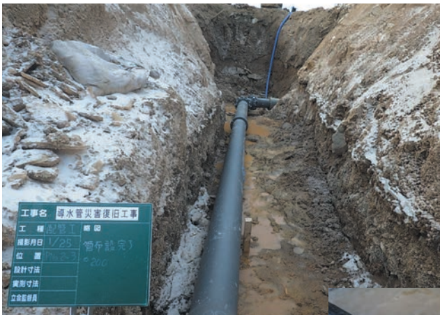
写真9 呼び径200 GX形布設状況
