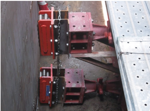
写真1 ガイドローラー設置
