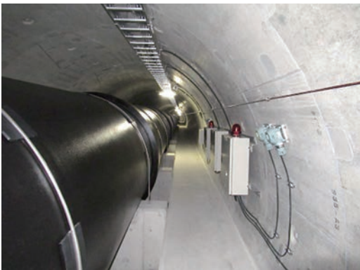
写真8 完成写真(坑内)
