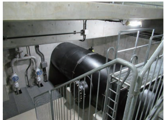
写真9 完成写真(立坑部)
