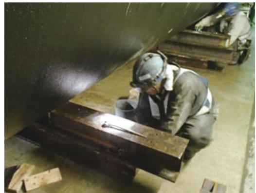
写真7 管受台施工状況
