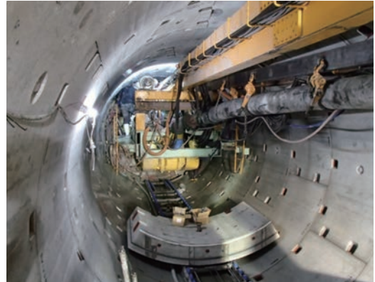
写真5 シールド掘進状況
