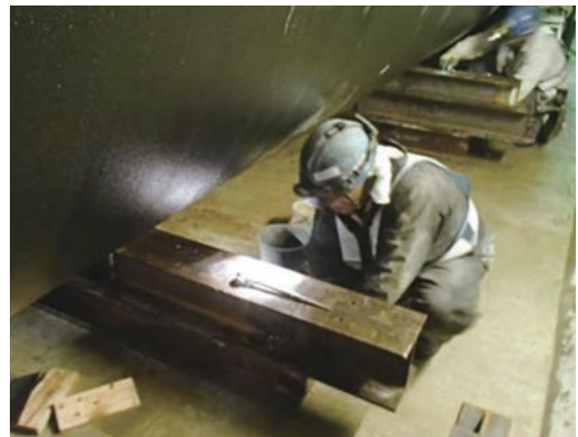
写真7 管受台施工状況
