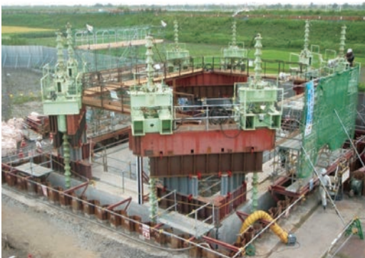
写真2 ケーソン沈設状況
