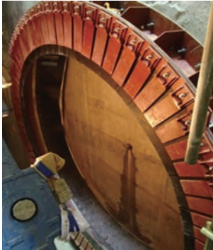
写真4 発進立坑坑口
