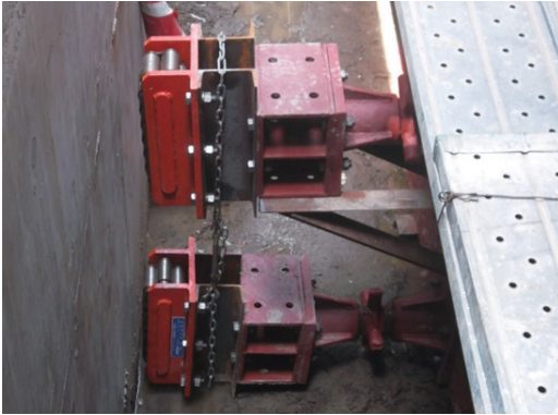
写真1 ガイドローラー設置
