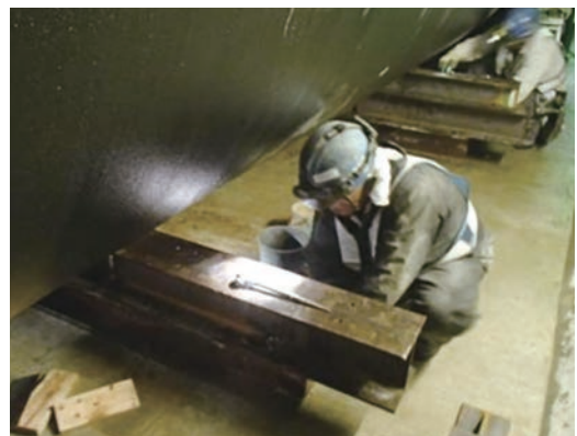
写真7 管受台施工状況
