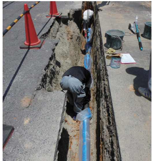
写真1 NS形E種管の施工状況写真
