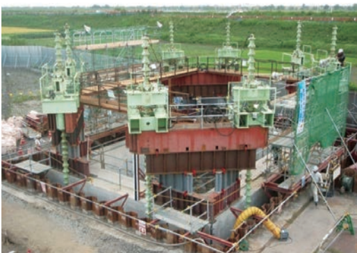
写真2 ケーソン沈設状況
