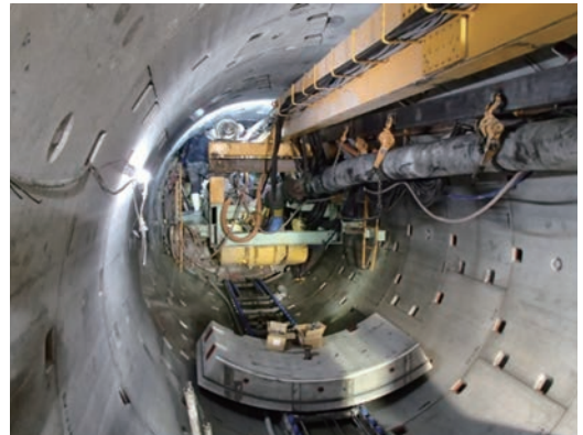
写真5 シールド掘進状況
