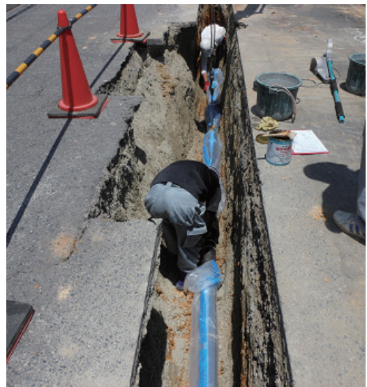
写真1 NS形E種管の施工状況写真
