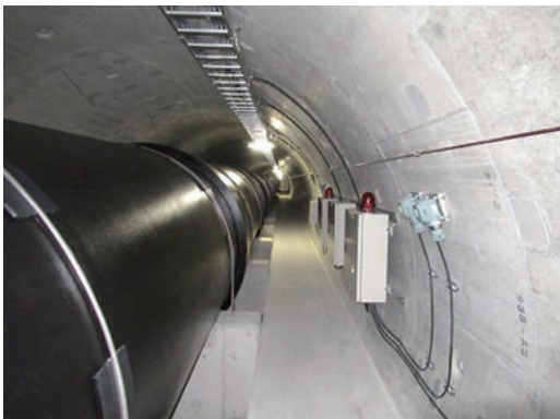
写真8 完成写真(坑内)
