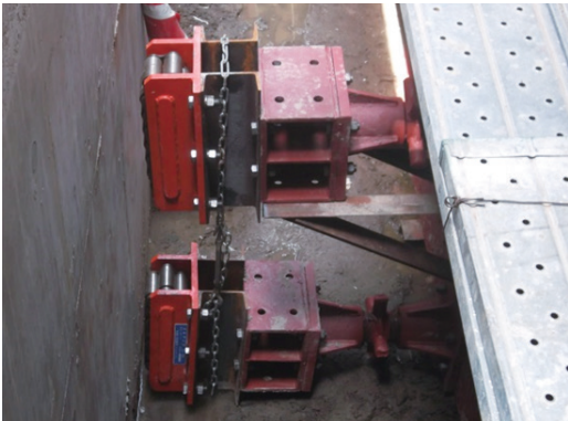
写真1 ガイドローラー設置
