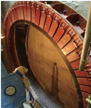
写真4 発進立坑坑口
