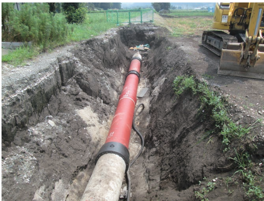
熊本県県北広域本部阿蘇地域振興局 A L W形 呼び径 600 大切畑地区県単農地等災害復旧事業第3号工事
