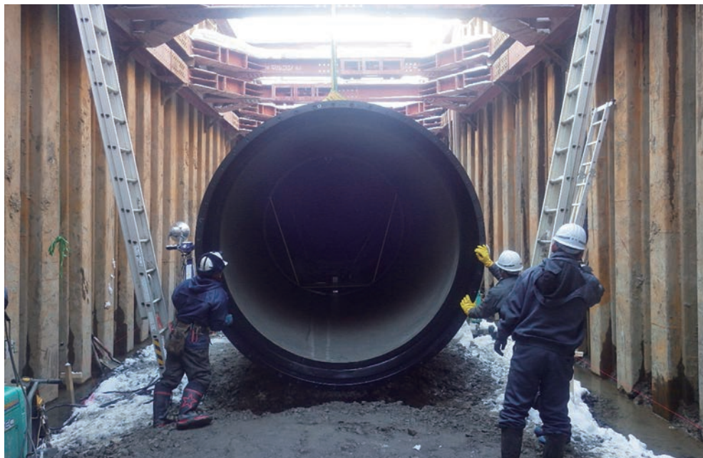
北海道上川総合振興局 旭川建設管理部 S形 呼び径 2600
