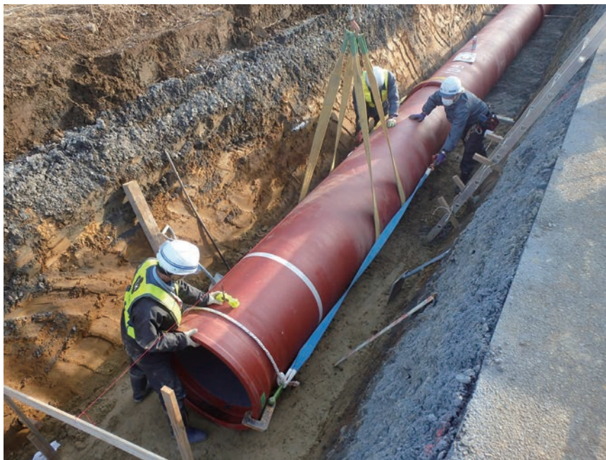
関東農政局那珂川沿岸農業水利事業所 A L W形 呼び径 800
