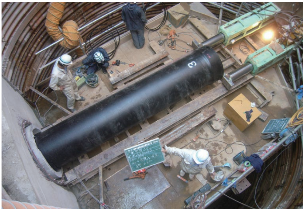
兵庫県宝塚市上下水道局 PN形 呼び径 800
