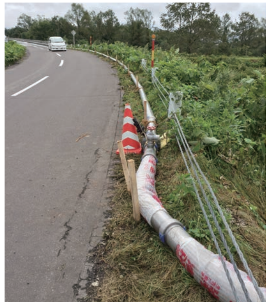
写真2 応急復旧状況
