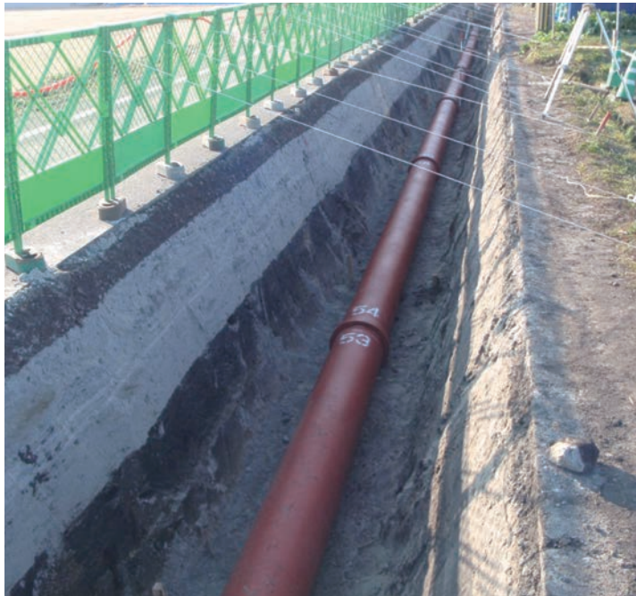
九州農政局南部九州土地改良調査管理事務所
