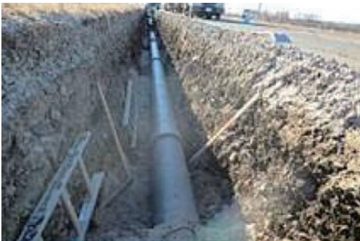
写真6 GX形管の布設状況
