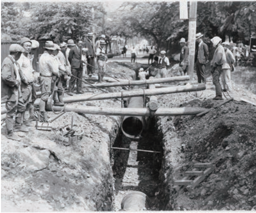
写真1 呼び径500配水管布設工事 (昭和8年6月17日)
