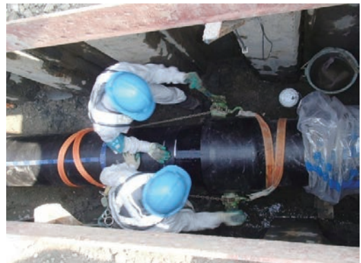
写真4 水道管路の接合状況
