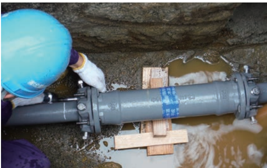
写真 2 S50形ダクタイル鉄管の施工状況
