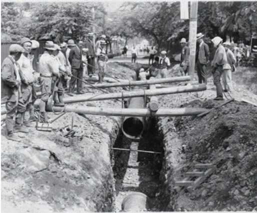
写真1 呼び径500配水管布設工事 (昭和8年6月17日)
