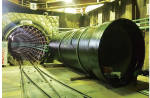
写真2 導水施設の二重化整備状況
