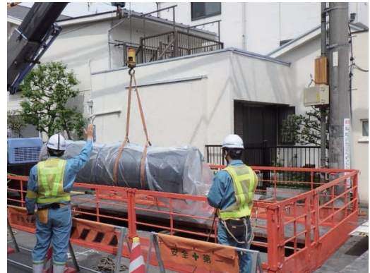
写真3 水道管路の吊込み状況
