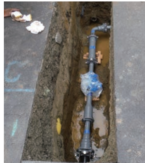
写真 2 S50形ダクタイル鉄管の施工状況
