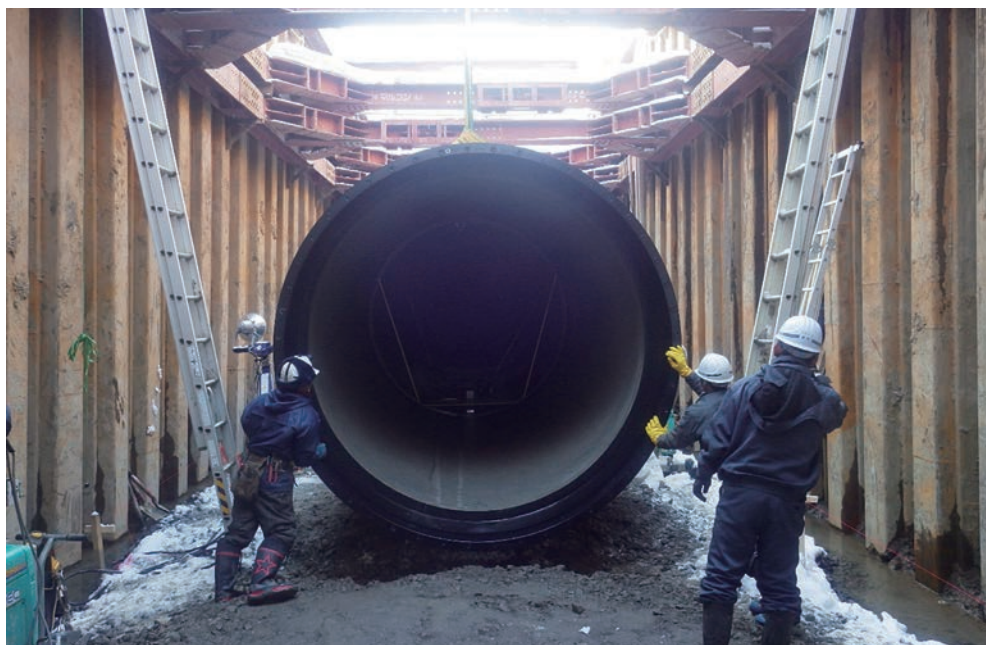
北海道上川総合振興局 旭川建設管理部 S 形 呼び径 2600
