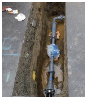
写真 2 S50形ダクトイル鉄管の施工状況
