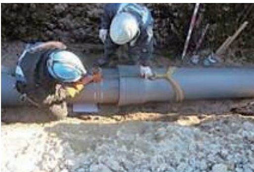
写真5 GX形管の接合状況
