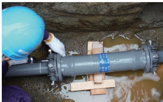
写真 2 S50形ダクトイル鉄管の施工状況
