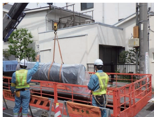
写真3 水道管路の吊込み状況
