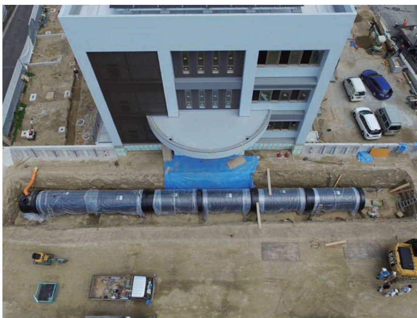
広島県廿日市市水道局 LUF 形耐震形貯水槽 100m 3 呼び径 2000
