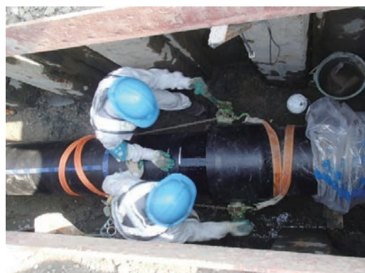
写真4 水道管路の接合状況
