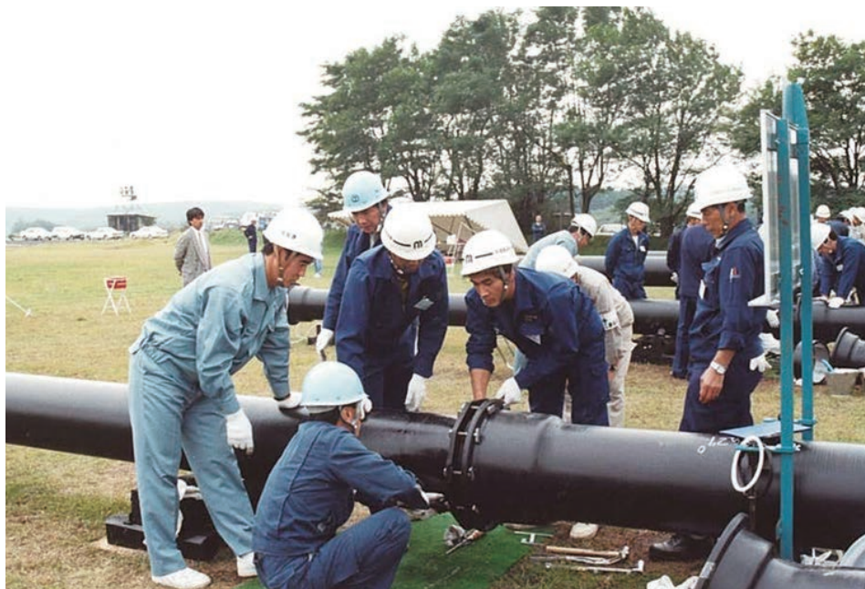
ダクトイル鉄管技術講習会 (S・SII・KF形管)への参加 H7.10
