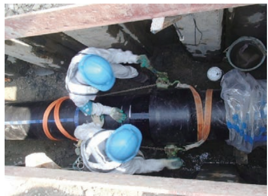
写真4 水道管路の接合状況
