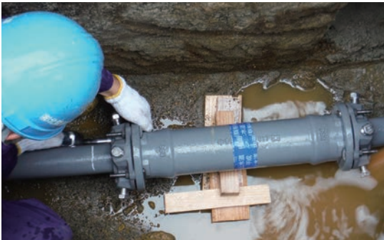
写真 2 S50形ダクタイル鉄管の施工状況
