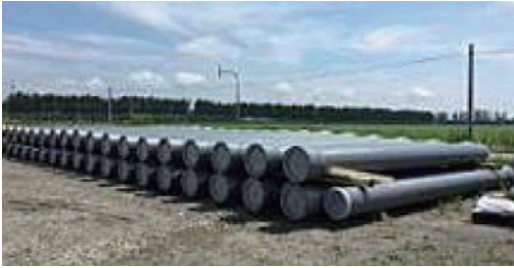
写真3 納入されたGX形管
