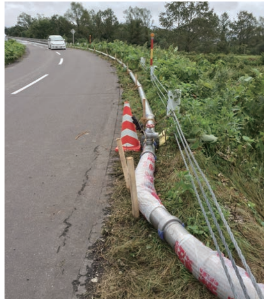
写真2 応急復旧状況
