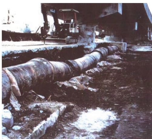
阪神・淡路大震災で 被害を受けなかった 耐震継手管 S形 呼び径700
