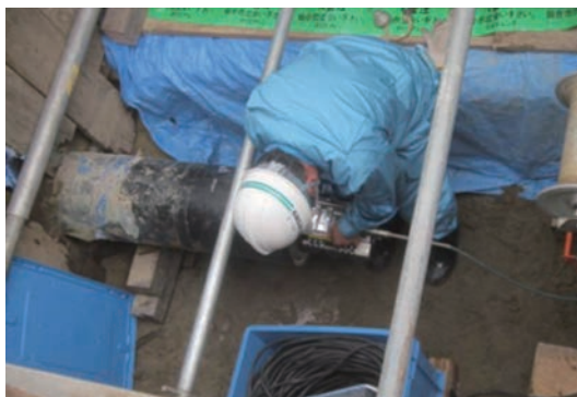
写真 7 カメラ挿入状況
