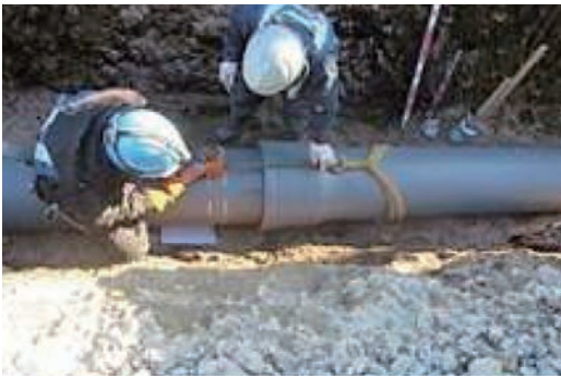
写真5 GX形管の接合状況
