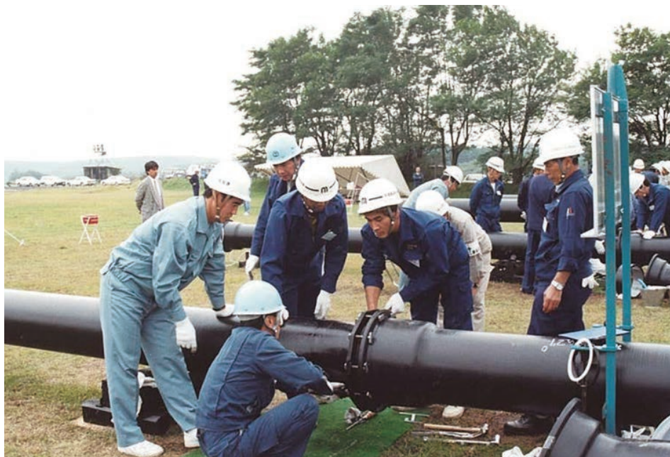
ダクタイトイル鉄管技術講習会 (S・SII・KF形管)への参加 H7.10
