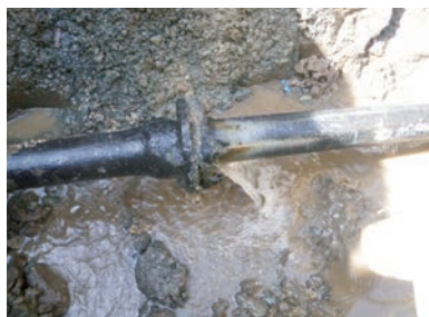
DAφ75 抜け 漏水状況
