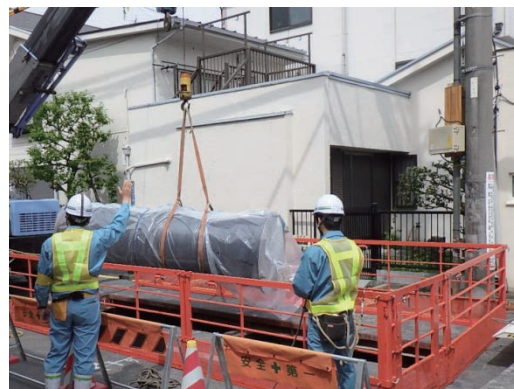
写真3 水道管路の吊込み状況
