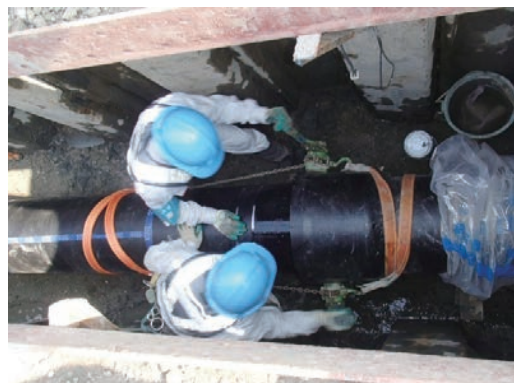
写真4 水道管路の接合状況
