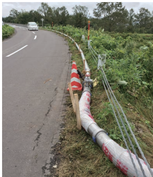
写真2 応急復旧状況
