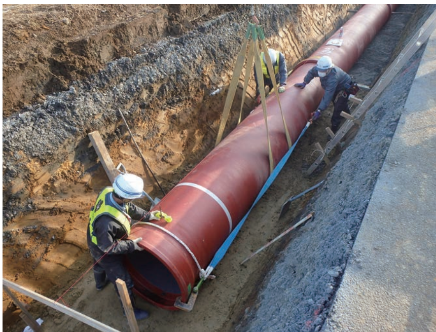
関東農政局那珂川沿岸農業水利事業所 A L W形 呼び径 800
