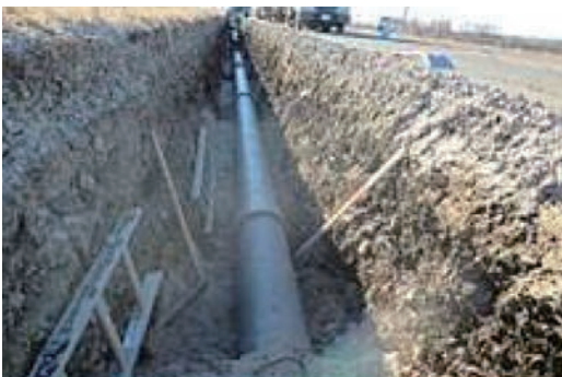
写真6 GX形管の布設状況
