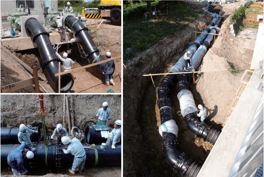
写真3 導水管渠(NS形呼び径700)施工状況(全景)
