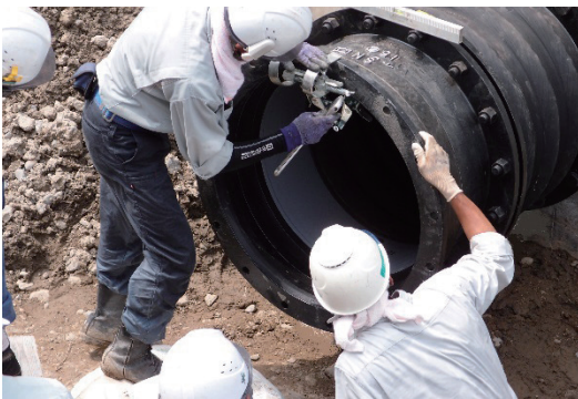
写真1 継手施工状況
