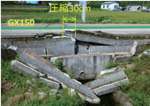
写真5 耐震継手ダクタイトイル鉄管の布設場所(嘉島町) <呼び径150GX形ダクタイトイル鉄管>
