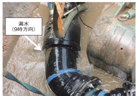
写真7 漏水状況
