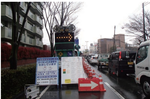
写真2 交通規制状況
