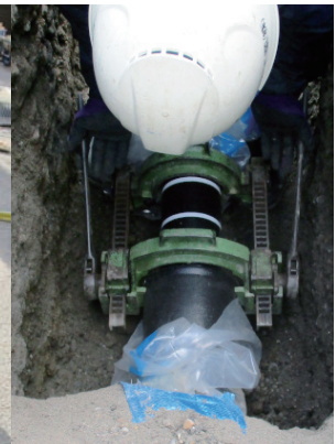
写真3 施工状況 (NS・ジャッキ)
