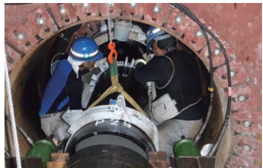
写真4 PN形管継手状況
