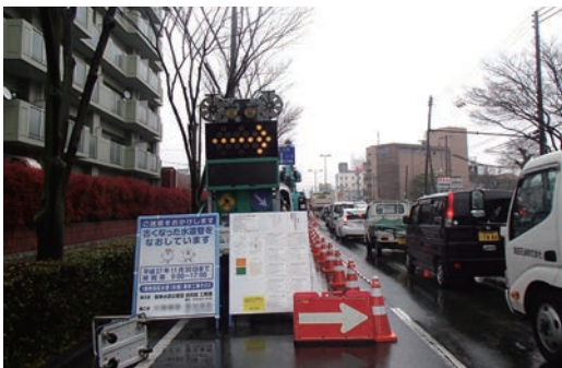
写真2 交通規制状況
