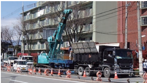
写真1 立坑築造状況
