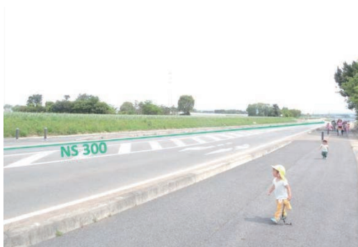
写真3 耐震継手ダクティル鉄管の布設場所(益城町) <呼び径300NS形ダクティル鉄管>
