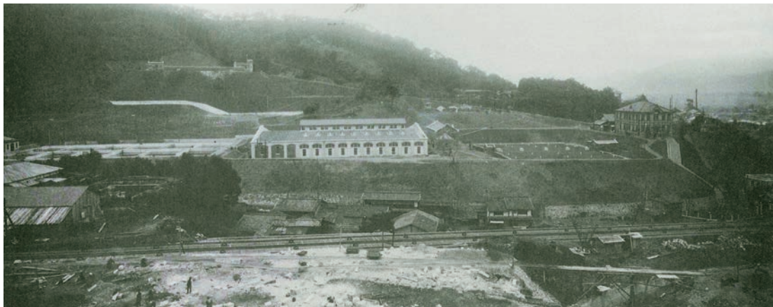
写真1:完成時の蹴上浄水場全景(明治45年3月26日撮影) (左から沈殿池、ろ過場、低区配水池、管理棟、山の中腹には高区配水池、手前は琵琶湖疏水のインクライン)
