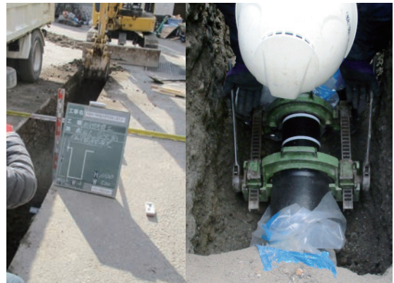
写真2 施工状況 (掘削幅50cm)
