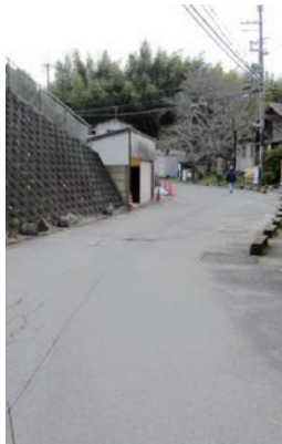
写真1 施工場所の状況
