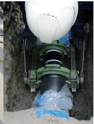
写真3 施工状況 (NS・ジャッキ)
