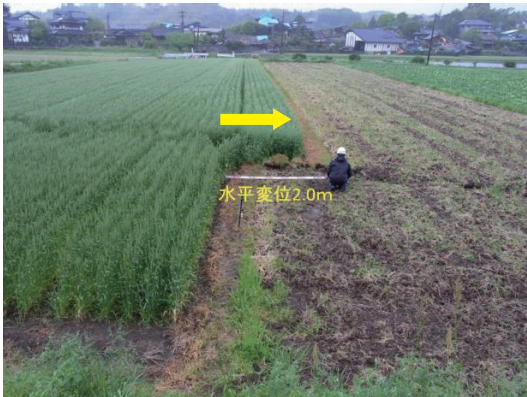
写真1 益城町堂園の断層
