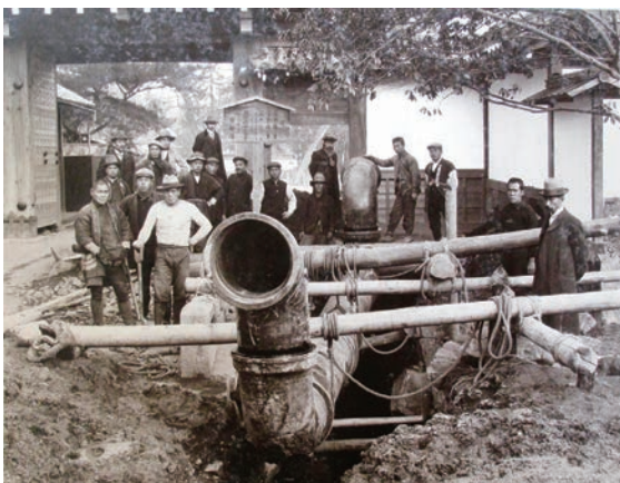
写真2：知恩院南門前の配水管布設工事 (明治44年1月24日撮影)
