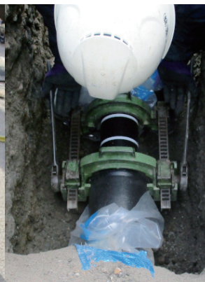
写真3 施工状況 (NS・ジャッキ)
