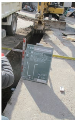
写真2 施工状況 (掘削幅50cm)
