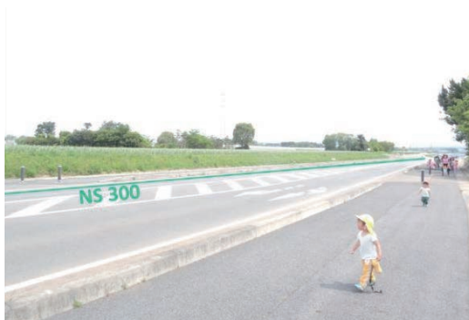
写真3 耐震継手ダクティル鉄管の布設場所(益城町) ＜呼び径300NS形ダクティル鉄管＞
