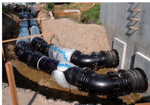
写真2 調圧水槽付近 鎖構造配管状況
