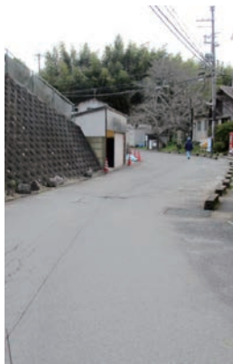
写真1 施工場所の状況
