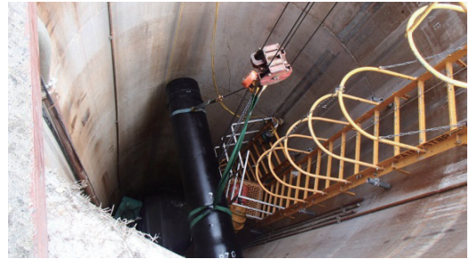
写真3 PN形管吊降し状況
