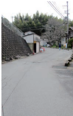
写真1 施工場所の状況
