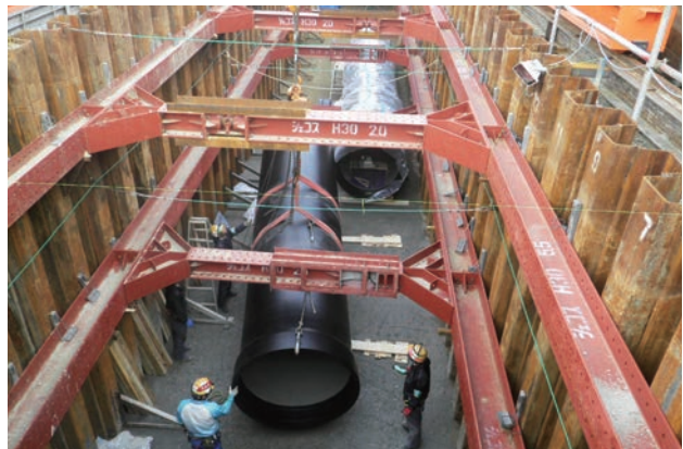
新規調整池の連絡管(φ1650S形ダクタイル鉄管) 布設状況
