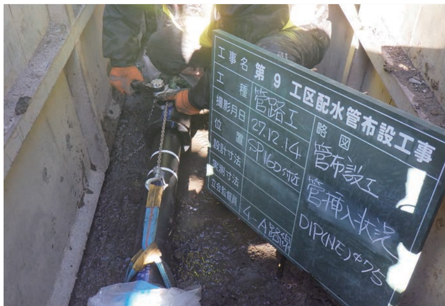
北海道 帯広市上下水道部 NS形E種 呼び径 75
