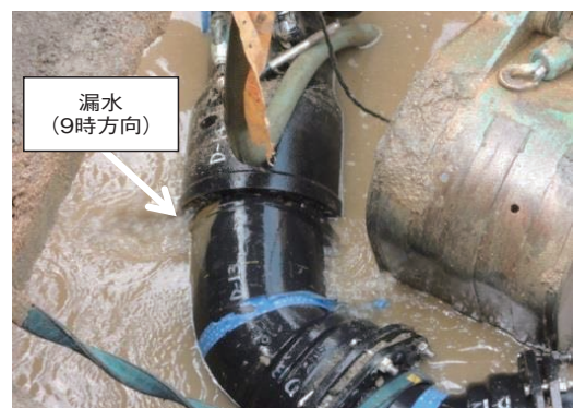
写真7 漏水状況
