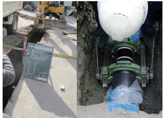
写真2 施工状況 (掘削幅50cm)
